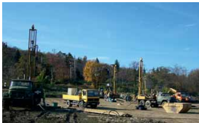
2. kép. Fúrási munkálatok Pannon Irodaháznál
